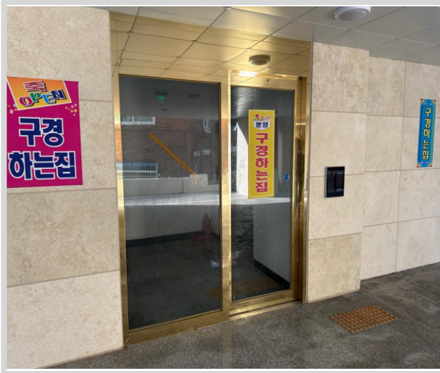
본건 B동 공동현관문 전경
